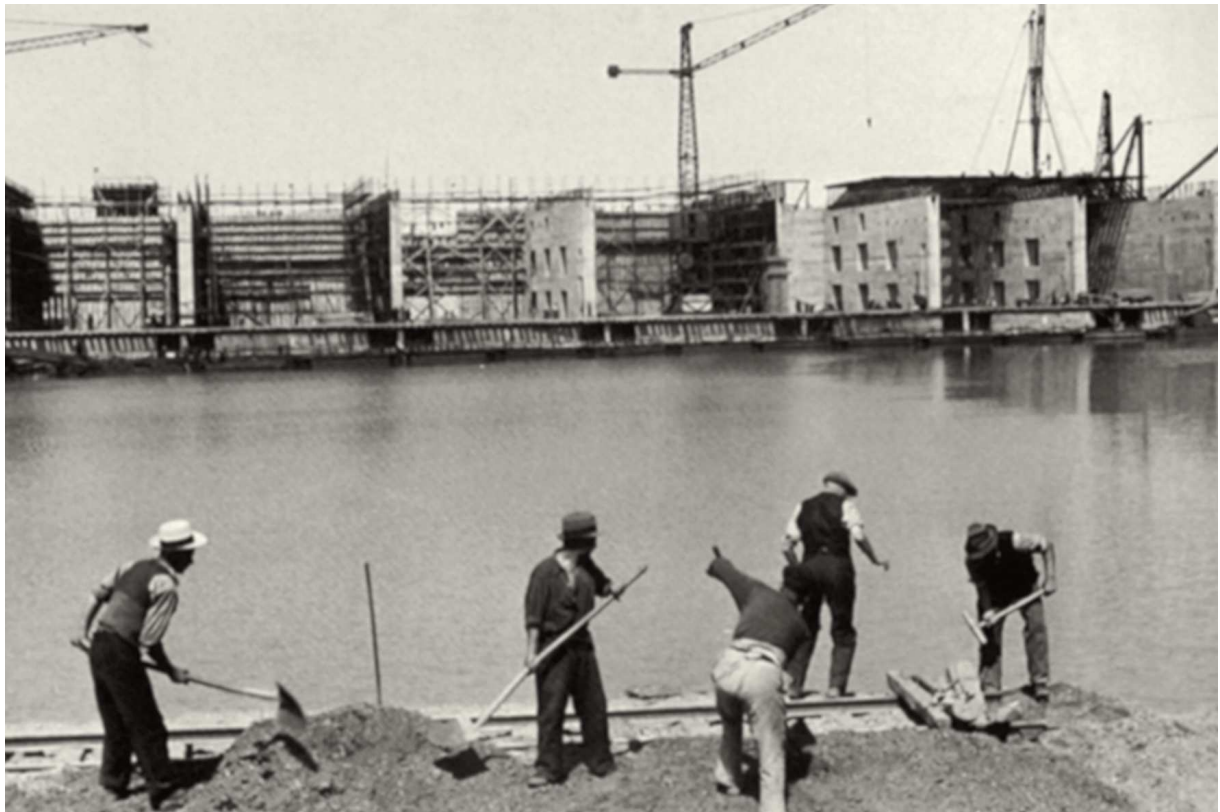
La base sous-marine en construction (1941-1943) (Mémoire de Bordeaux)
